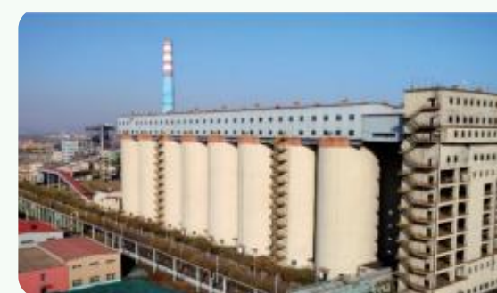
焦化储煤筒仓
