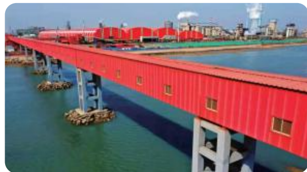
跨海皮带通廊
