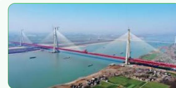
巢马铁路马鞍山公铁两用长江大桥（2100MPa 级）
