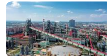
跨海皮带通廊
