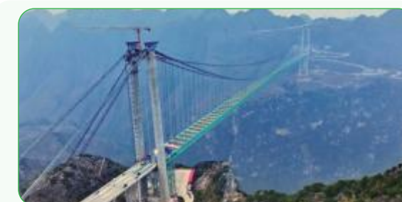
世界第一高桥 — 六安高速花江峡谷大桥
