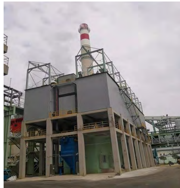
高炉热风炉烟气脱硫系统及热风炉排气筒
