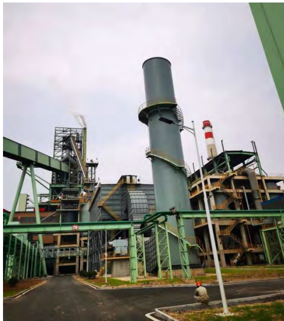
高炉出铁场除尘系统
