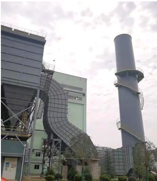
高炉-矿焦槽除尘系统
