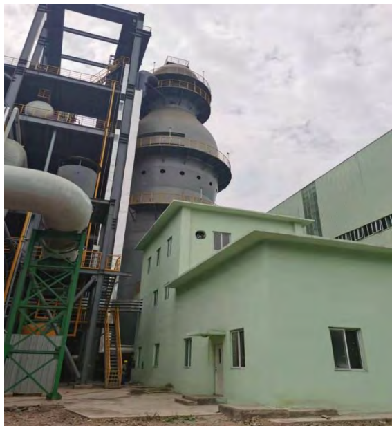
高炉热风炉
