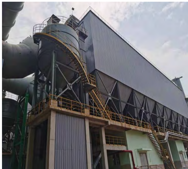
转炉二次烟气除尘系统
