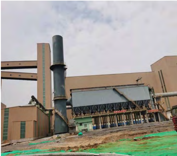
6#精炼炉除尘系统
