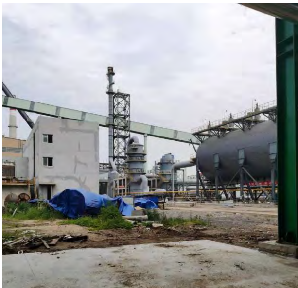
转炉一次除尘系统、煤气放散烟囱
