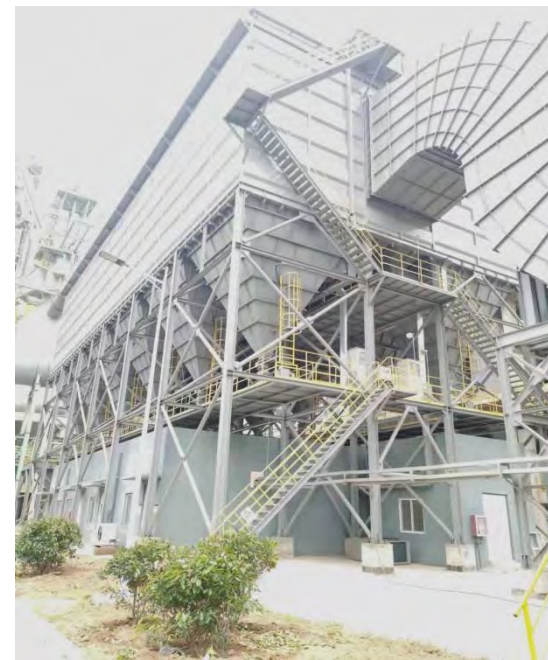
炼铁出铁场除尘器
