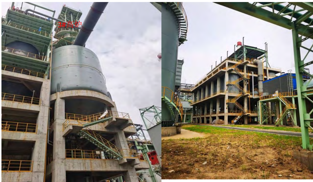
高炉煤气净化（重力除尘+干法除尘）
