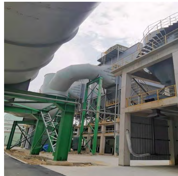
转炉三次烟气除尘系统
