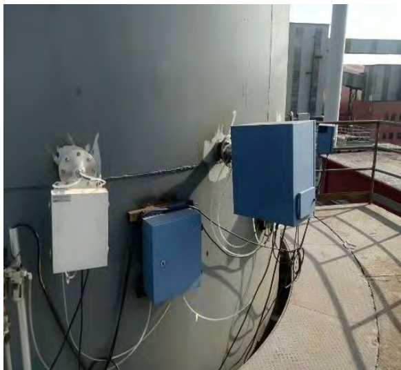
机尾除尘在线监测设备
