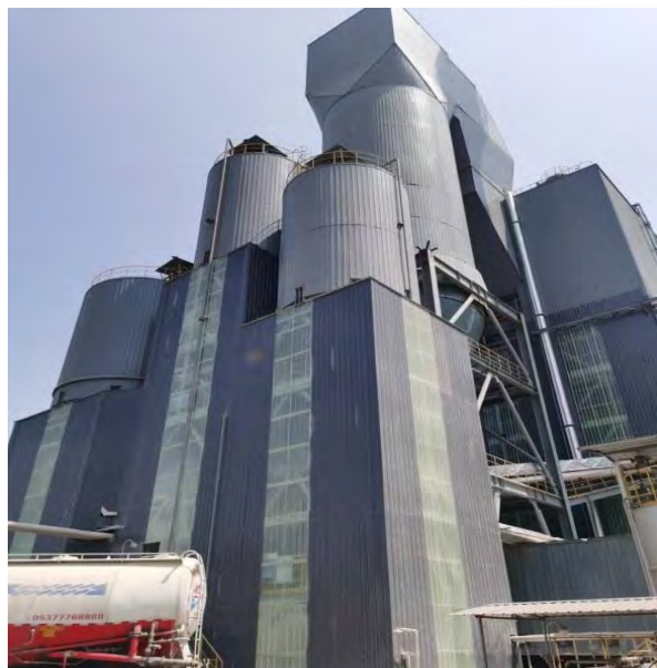
脱硫系统（消石灰仓和生石灰仓、灰库）
