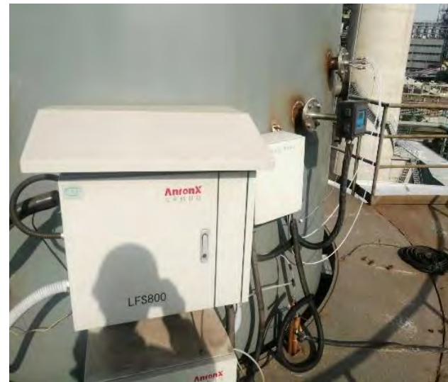
烧结机配料室除尘在线监测设备
