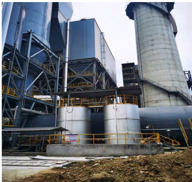
机头脱硝用 20%氨水储罐
