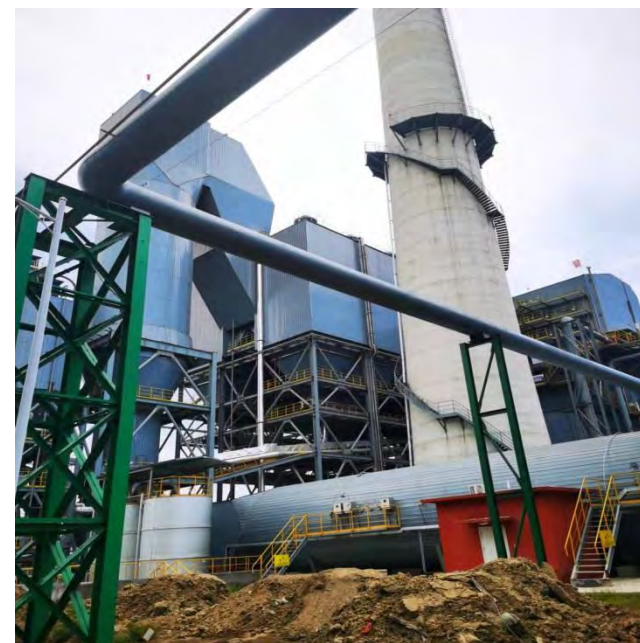
机头脱硫脱硝系统及烟囱
