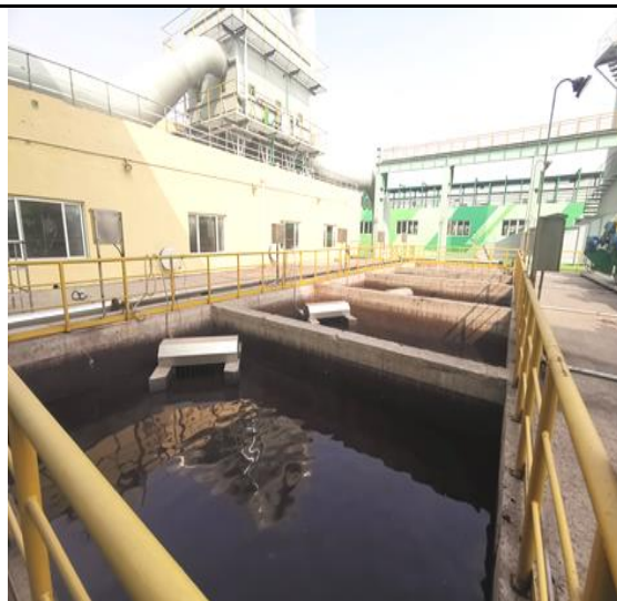
轧钢废水处理-圆盘除油器
