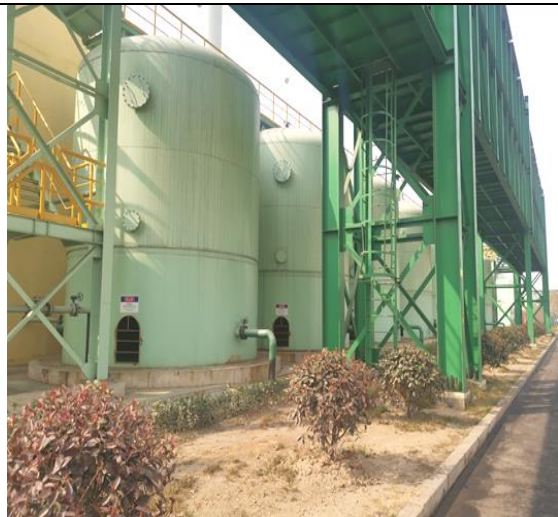
轧钢废水处理-高速过滤器
