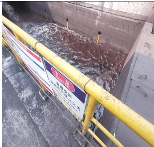
轧钢废水（进生产废水管网，再进入中法水务污水处理厂处理）
