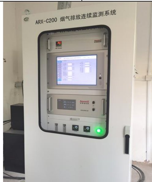
5#、6#高线加热炉烟气在线设备
