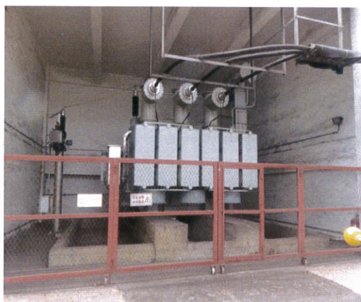
图 4-9 1#主变压器
