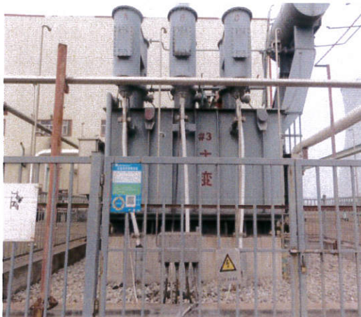
图 4-12 3#主变压器
