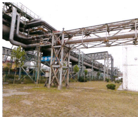
图 4-5 发电 110kV 升压站南侧
